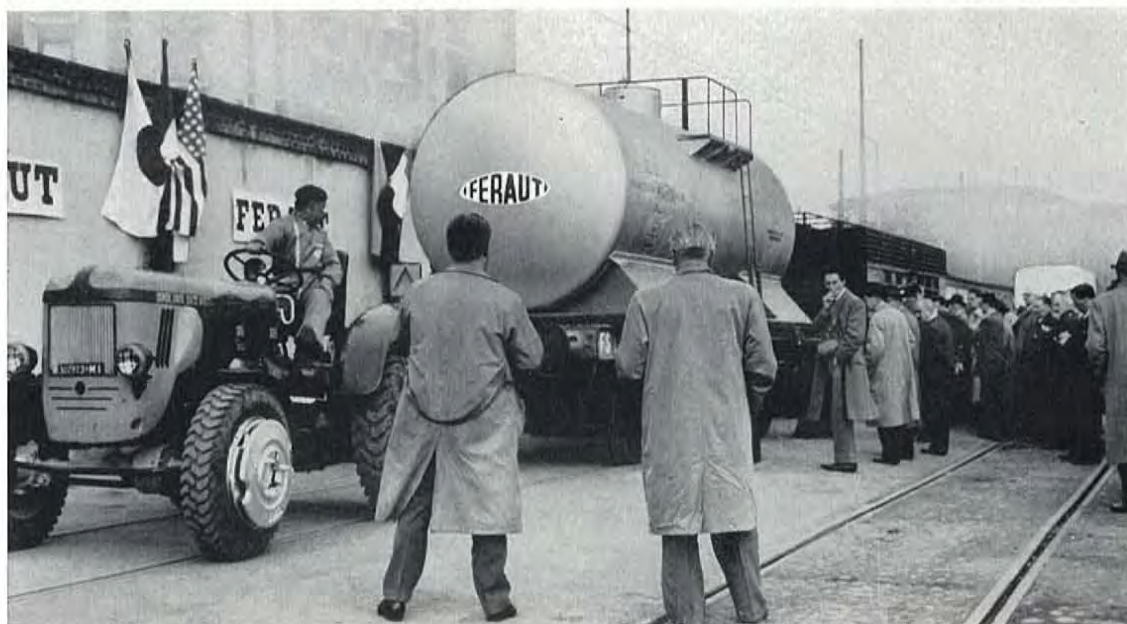
Il telaio ferroviario, con il serbatoio (tonn. 22) ed il rimorchio stradale con il contenitore a sponde alte, carico di traverse (tonn. 20), vengono condotti all'impianto per lo scambio dei contenitori.
